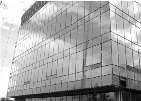
Construction du Centre, vue de l'extérieur, juin 2009
